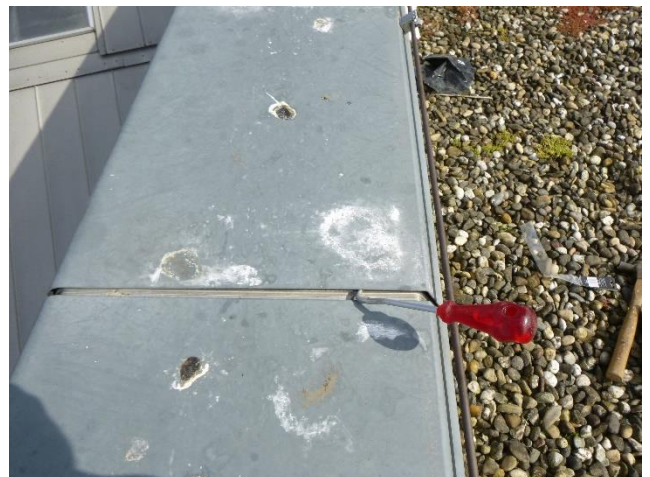
Foto 10 Aluminium afdekkappen sluiten niet goed aan op de klangen.
