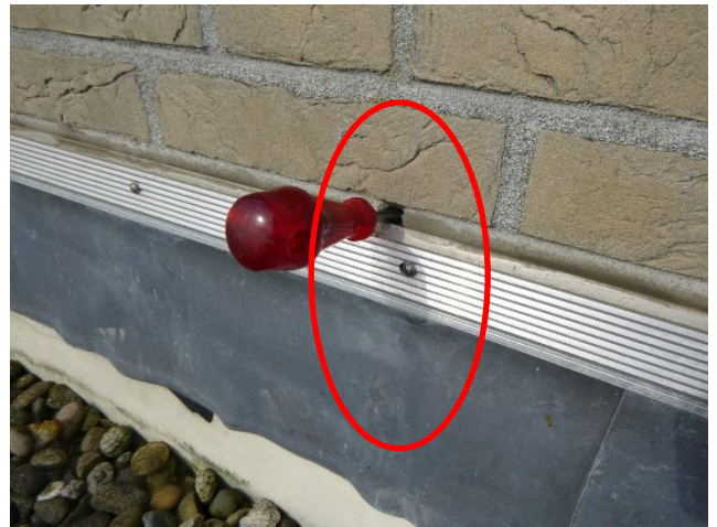
Foto 8 Inwateringspunt boven aluminium knelstrip bij open stootvoeg.
