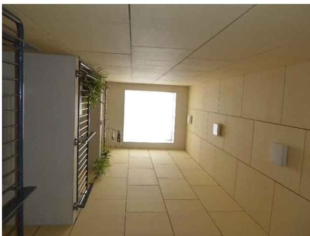
Foto 41 Overzicht lichtkoepel in trappenhuis, mogelijk aanpassen naar daktoegang.
