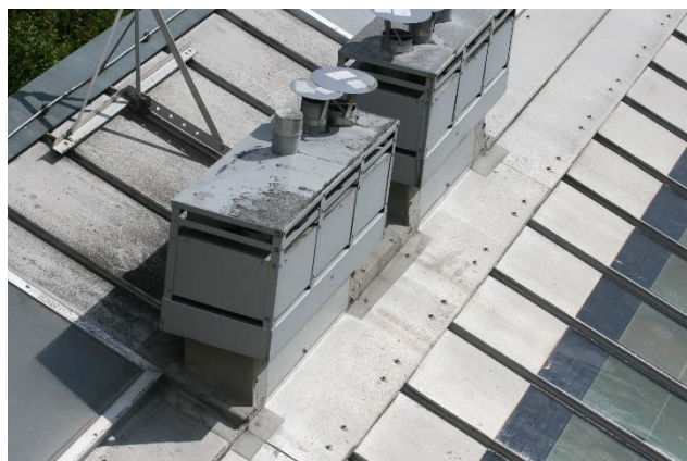
Foto 24 Overzicht verzamelkappen. Diverse uitwendige hoeken hersteld met een PMMA-coating.
