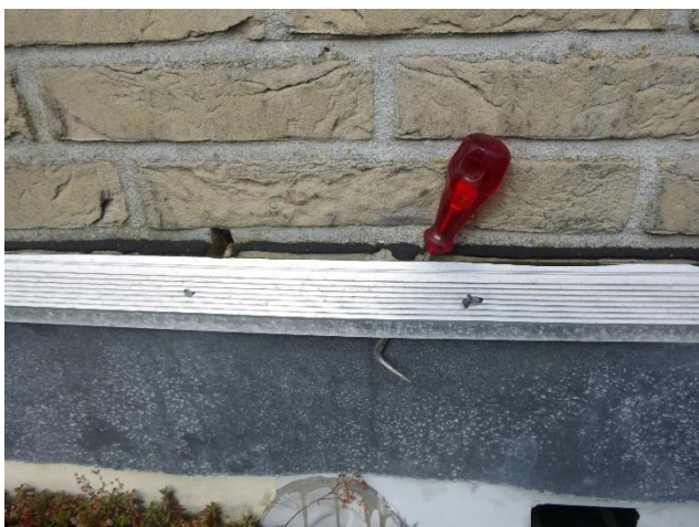
Foto 5 Aluminium knelstrip, omgekeerd aangebracht bevestigd met draadnagels en schroeven, is gedeeltelijk los.
