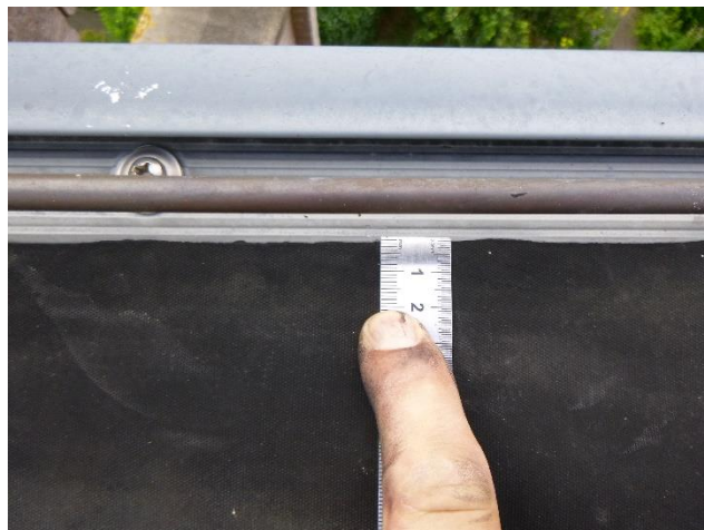
Foto 14 EPDM-stroken maximaal 20 mm aangebracht op aluminium daktrim.
