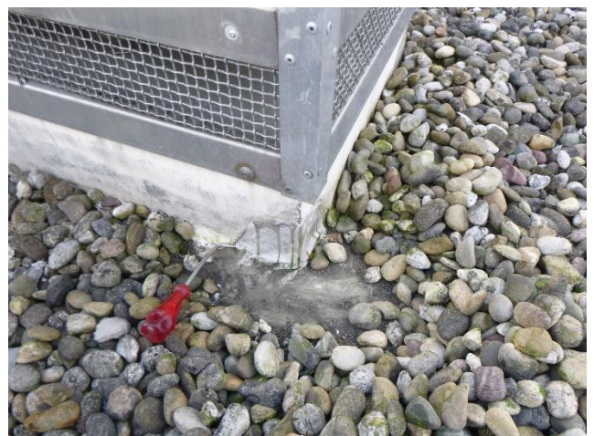
Foto 12 Inwateringspunt in de kim van de TPO-randstrook.
