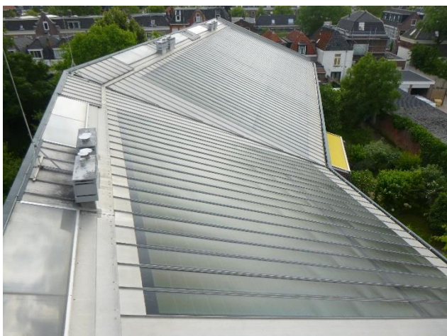
Foto 21 Overzicht dakvlak 1, metalen felsdaken voorzien van gekleefde amorfe PV-stroken.
