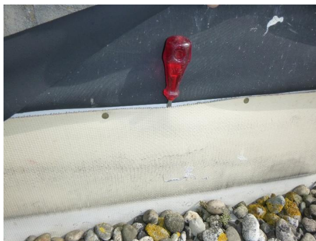
Foto 4 TPO-randstroken zijn mechanisch bevestigd met draadnagels, h.o.h. circa 300 mm.
