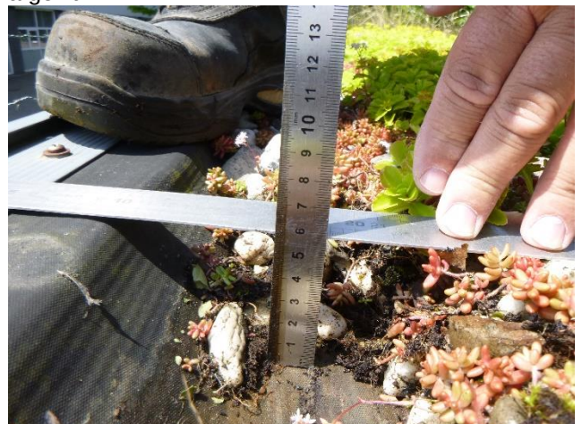
Foto 36 Gemeten dakrandhoogte vanaf dakvlak bedraagt 60 mm.
